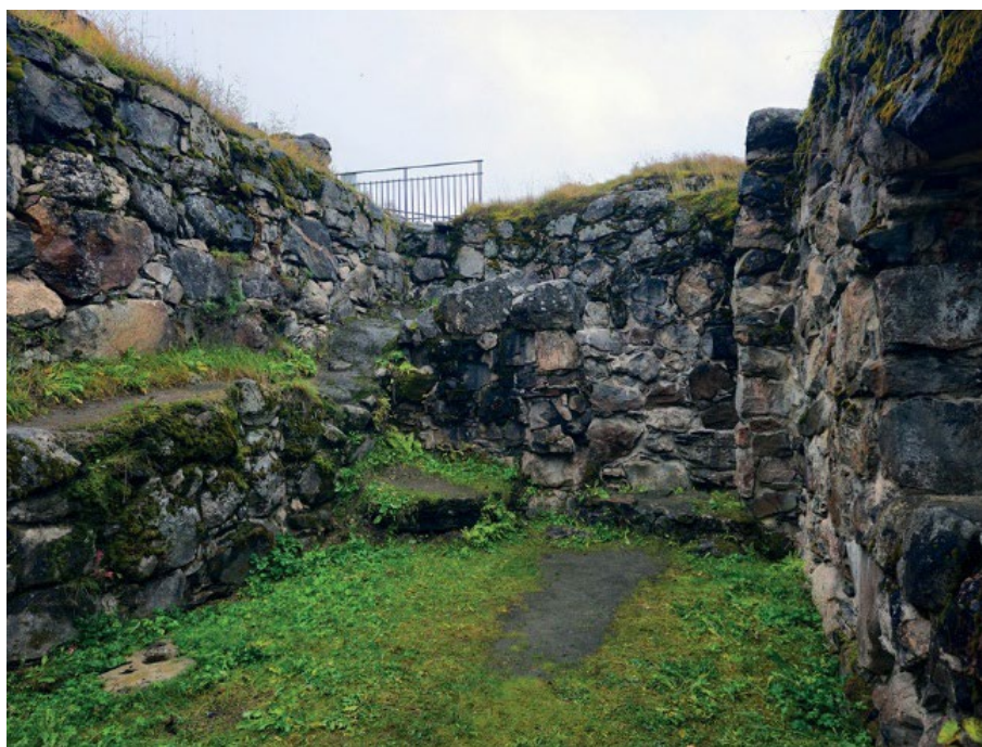
Kuva 14. Väentupa kuvattuna lännestä. Huoneen kulmassa näkyvissä 1600-luvun jälkimmäisen puolen pohjapiirroksen merkityn tulisijan perustus. Kuva: Tarja Knuutinen/Muuritutkimus Oy 2024. Mu-Tu424027Dg_13.
