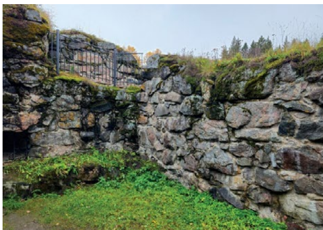
Kuva 7. Ns. Kirkkotuvan sisäpihan puoleisesta seinästä puuttuvan ikkuna-aukon kohta muurin etelä- ja pohjoispuolelta kuvattuna. Kuva: Tarja Knuutinen/ Muurututkimus Oy 2024. MuTu424027Dg_5–6.
