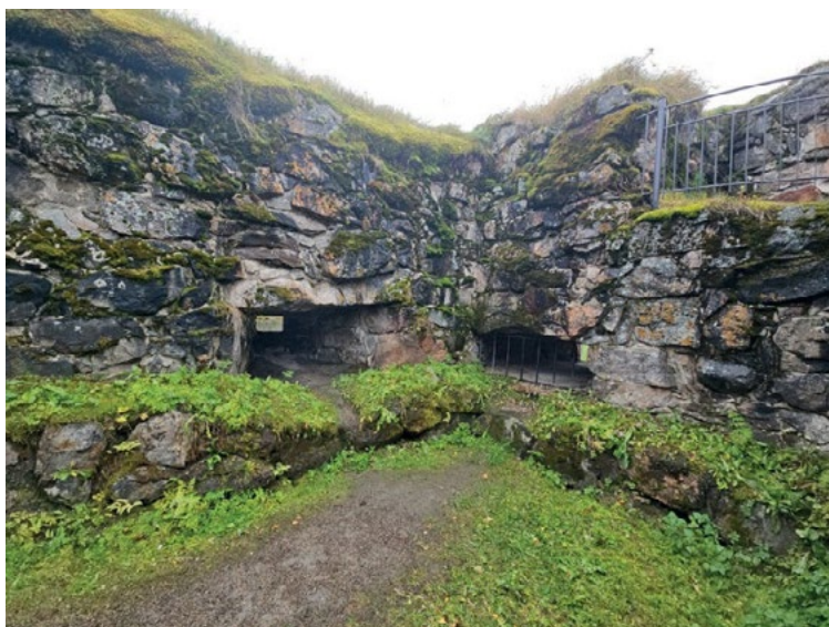
Kuva 6. Kirkkotuvan lounaiskulman ikkuna-/ampumaukot. Kuva: Tarja Knuutinen/Muuritutkimus Oy 2024. MuTu424027Dg_4.
