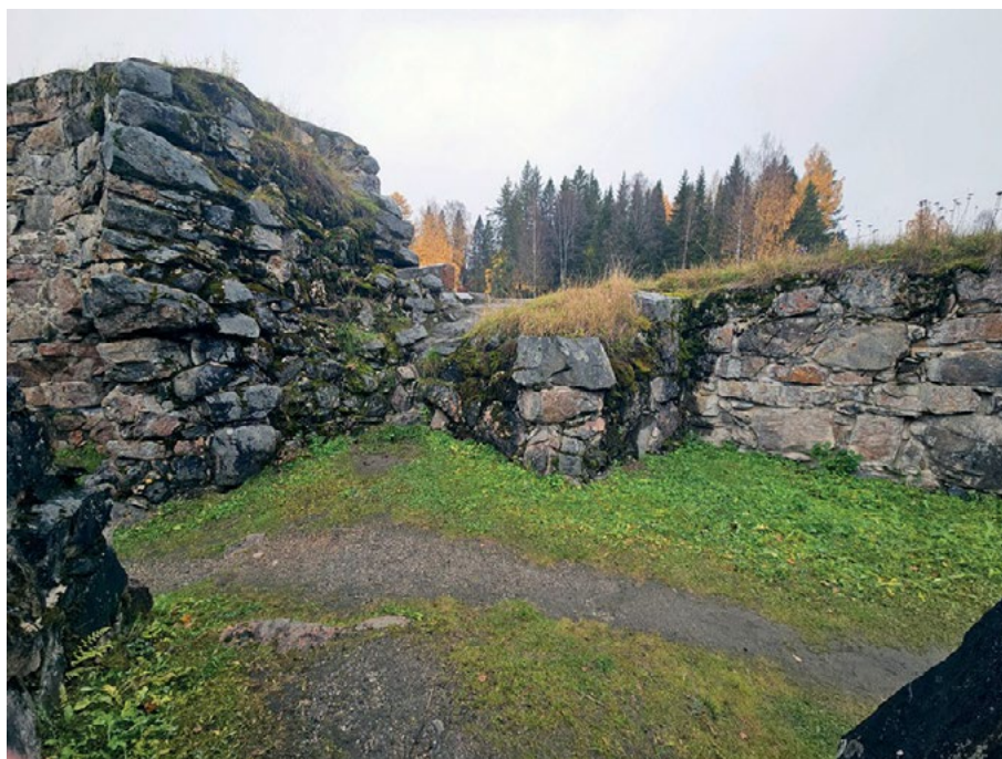
Kuva 13. Komendantinhuoneen ja ruutivaraston välinen alue. Huonetilojen välinen seinä ilmeisesti tuhoutui täysin vuoden 1716 räjähdyksessä. Vuoden 2001 koekuoppa 2 sijaitsi kuvan keskellä olevan muurikulman edustalla. Kuva: Tarja Knuutinen/Muuritutkimus Oy 2024. MuTu424027Dg_12.
