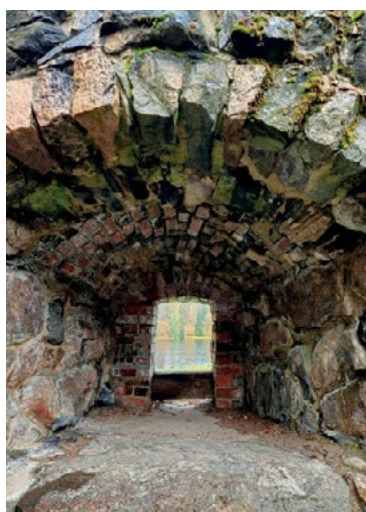
Kuvat 21a–c. Tiilirakenteita Kajaanin linnan ampuma-aukoissa. Vasen: läntisen rondellin eteläinen ampuma-aukko, lakikivessä erottuu punaista väriä. Keskellä: pohjoisen siipivarustuksen itäinen ampuma-aukko, jossa myös holvi on muurattu tiilestä. Oikealla: itäisen rondellin kaakkoinen ampuma-aukko, jossa selvästi eriaikaisia tiilimuurauksia. Kuvat: Tarja Knuutinen / Muuritutkimus Oy 2024. MuTu424027Dg_17–19.
