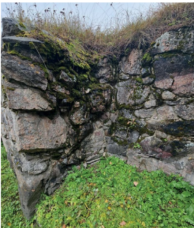
Kuva 23. Tiilimuurausta komendantinhuoneen muurisyvennyksen länsiseinässä. Kuva: Tarja Knuutinen / Muuritutkimus Oy 2024. MuTu424027Dg_21.
