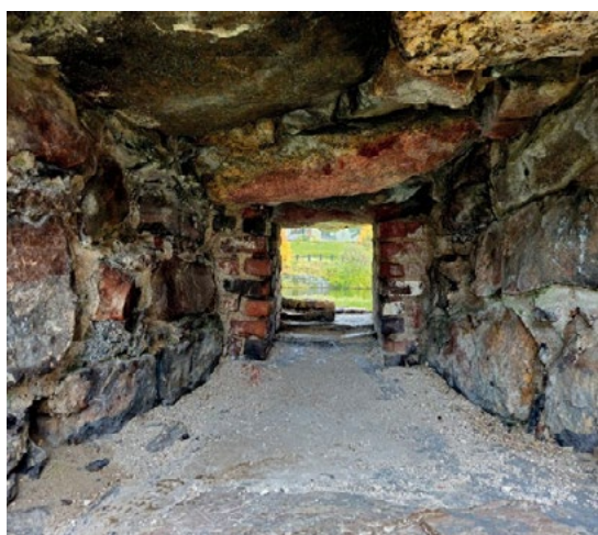
Kuvat 21a–c. Tiilirakenteita Kajaanin linnan ampuma-aukoissa. Vasen: läntisen rondellin eteläinen ampuma-aukko, lakikivessä erottuu punaista väriä. Keskellä: pohjoisen siipivarustuksen itäinen ampuma-aukko, jossa myös holvi on muurattu tiilestä. Oikealla: itäisen rondellin kaakkoinen ampuma-aukko, jossa selvästi eriaikaisia tiilimuurauksia. Kuvat: Tarja Knuutinen / Muuritutkimus Oy 2024. MuTu424027Dg_17–19.
