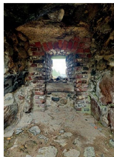
Kuvat 21a–c. Tiilirakenteita Kajaanin linnan ampuma-aukoissa. Vasen: läntisen rondellin eteläinen ampuma-aukko, lakikivessä erottuu punaista väriä. Keskellä: pohjoisen siipivarustuksen itäinen ampuma-aukko, jossa myös holvi on muurattu tiilestä. Oikealla: itäisen rondellin kaakkoinen ampuma-aukko, jossa selvästi eriaikaisia tiilimuurauksia. Kuvat: Tarja Knuutinen / Muuritutkimus Oy 2024. MuTu424027Dg_17–19.
