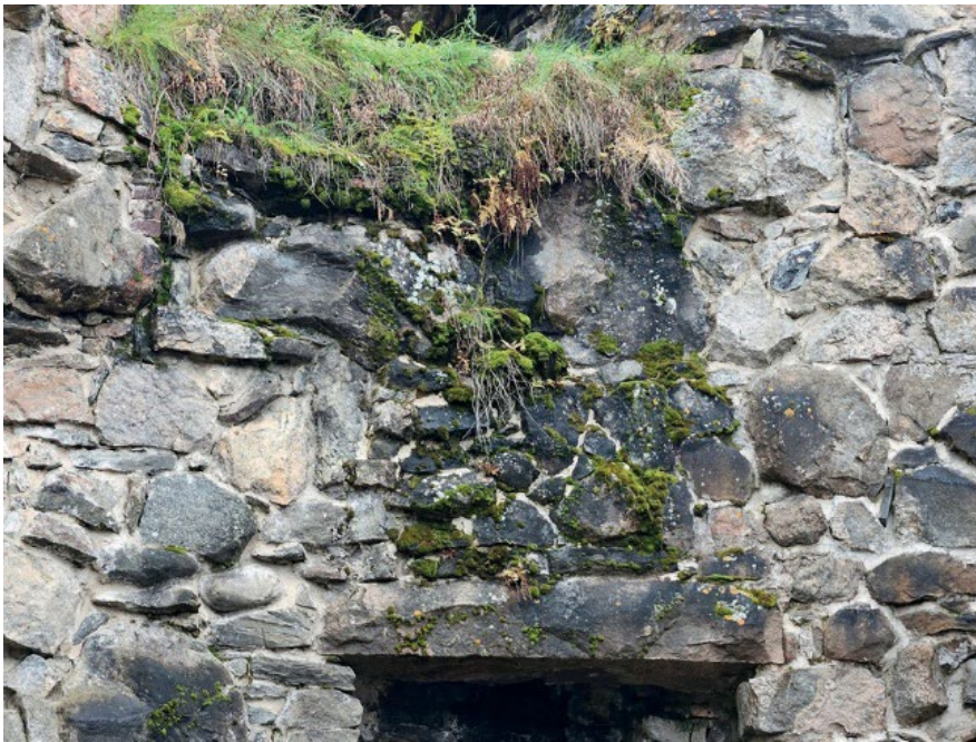
Kuva 22. Kuvan vasemmassa yläaidassa tiilirakennetta itäisestä rondellista linnan ulkopuolelle johtavan oviaukon yläpuolella, muurin sisäpinnalla. Kuvan keskellä erotuu oviaukon lakikiven päällä kolmioi-mainen täytemuuraus. Kuva: Tarja Knuutinen / Muuritutkimus Oy 2024. MuTu424027Dg_20.
