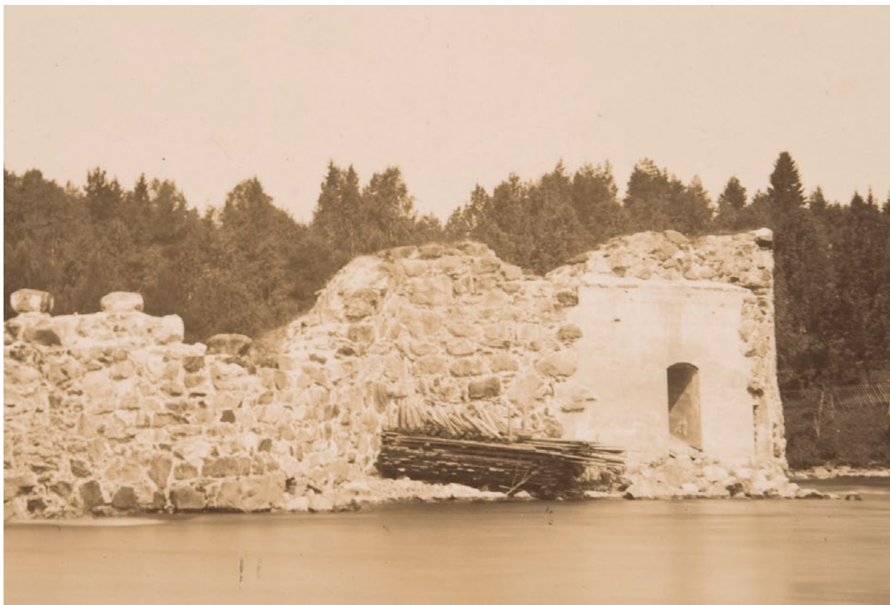
Kuvassa näkyy yläjuoksun puoleinen rondeli, joka on korjattu tiilirakenteisena ja tiilirakenteet rapattu. Etualalla näkyy lautoja ja pukkeja, jotka ovat todennäköisesti korjaustyön aikaisia telineiden osia. n. 1900 MV, finna.fi
