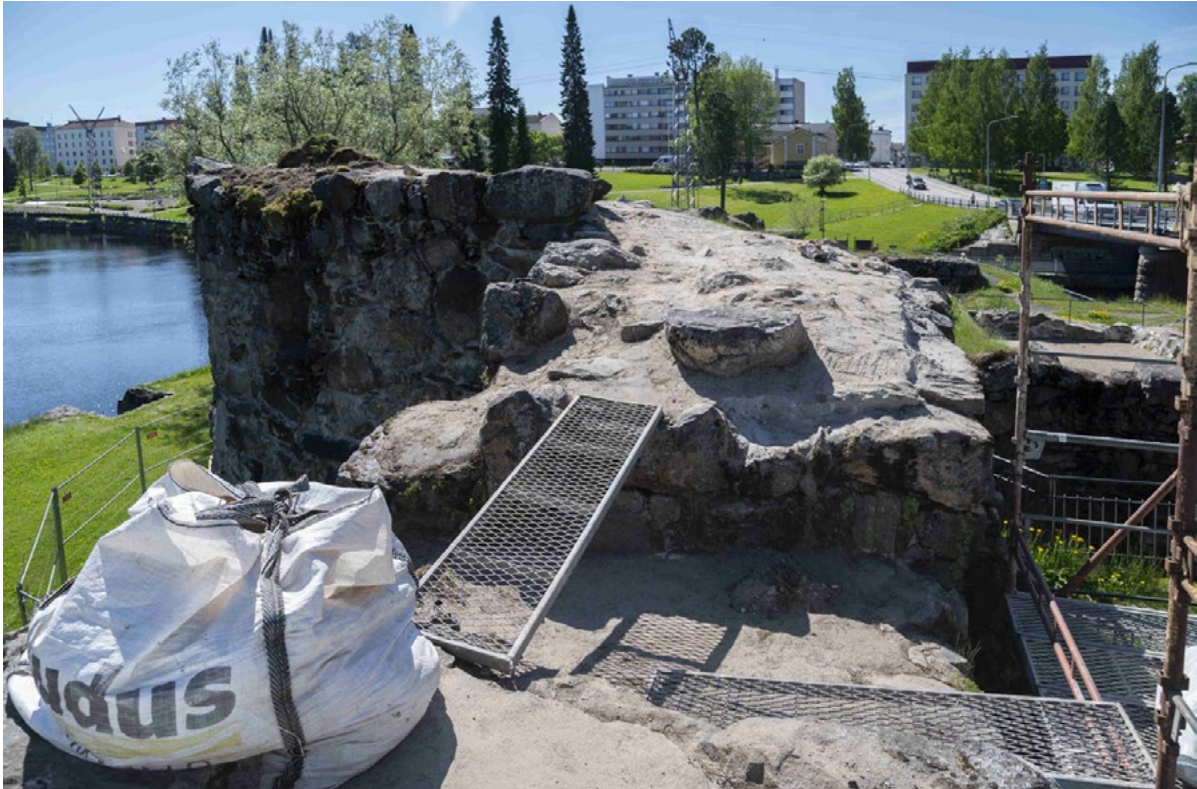
Länsikulman vedeneristyksen korjausta. Kuva: Pekka Agarh/Kivityö Kaseva Oy.
