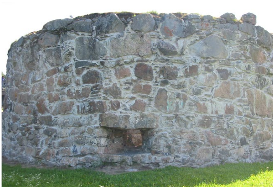
Alajuoksun puoleisen muurin saumausta valmiina, 17.6.2004. Kuva: Sanna Ihatsu.
