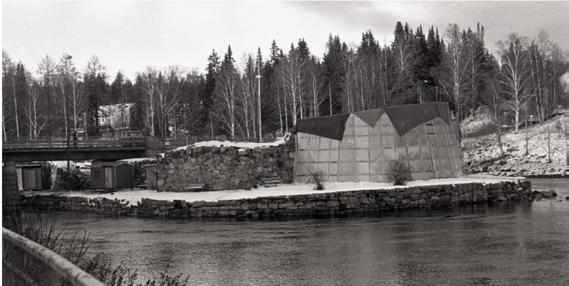
Ylävirran puoleinen torni suojattuna telttarakennelmalla talvitöiden tekemistä varten. 1980, Kainuun museon kuva-arkisto.
