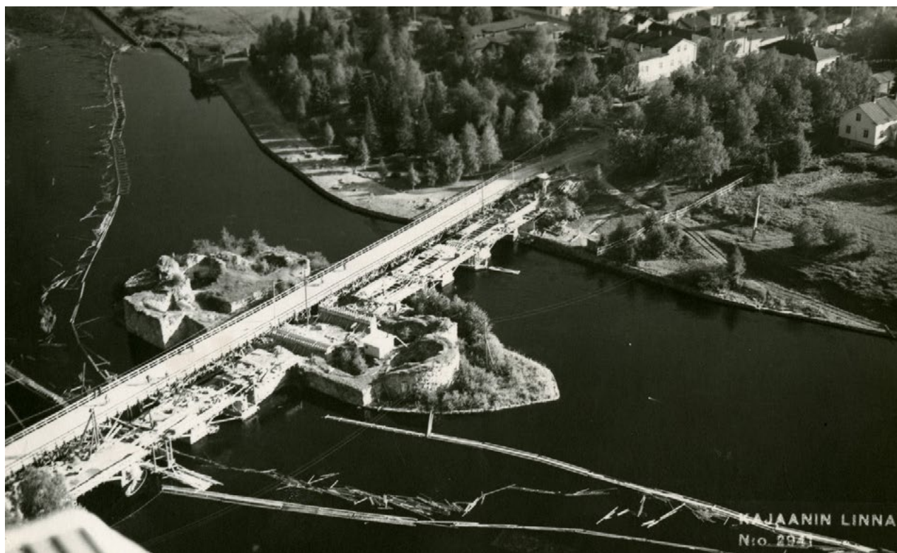
Uusi maantiesilta rakenteilla 1936. Kuva: Veljekset Karhumäki, Kainuun museon kuvakokoelma.
