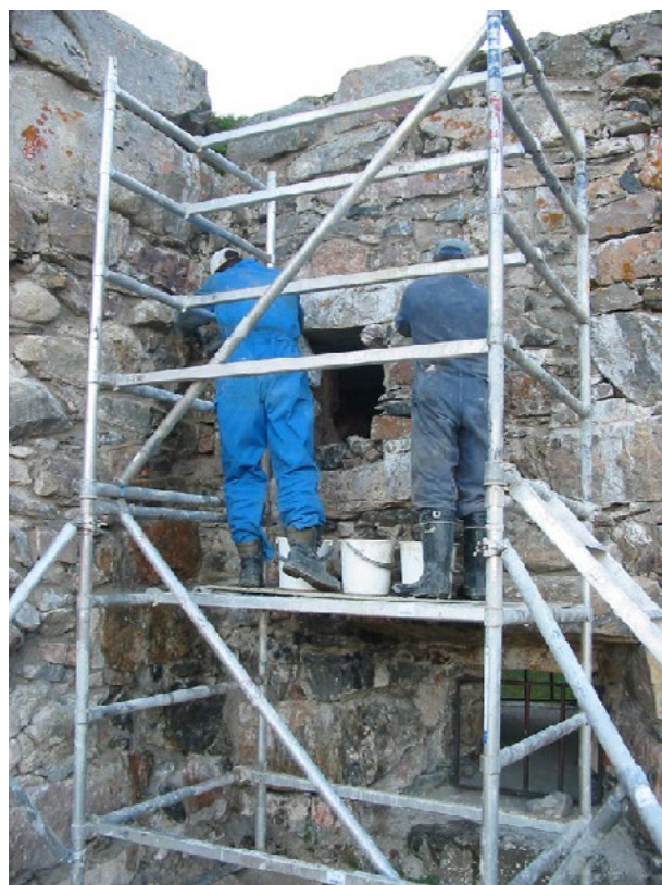
Muurin saumausta alajuoksun puoleisessa osassa, 15.10.2003. Kuva. Sanna Ihatsu.
