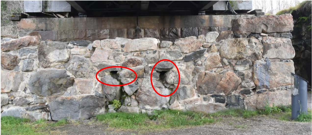
Esimerkki 1 hallitusta vesien poisjohtamisesta: vuosien 2003–2008 korjauksessa jätettiin betonikansi "kouruksi" taustalle ja muurin reunoja nostettiin ylemmäs. Veden poistumiselle jätettiin julkisivuun kaksi vesireittiä. Kuva: Sanna Ihatsu.
