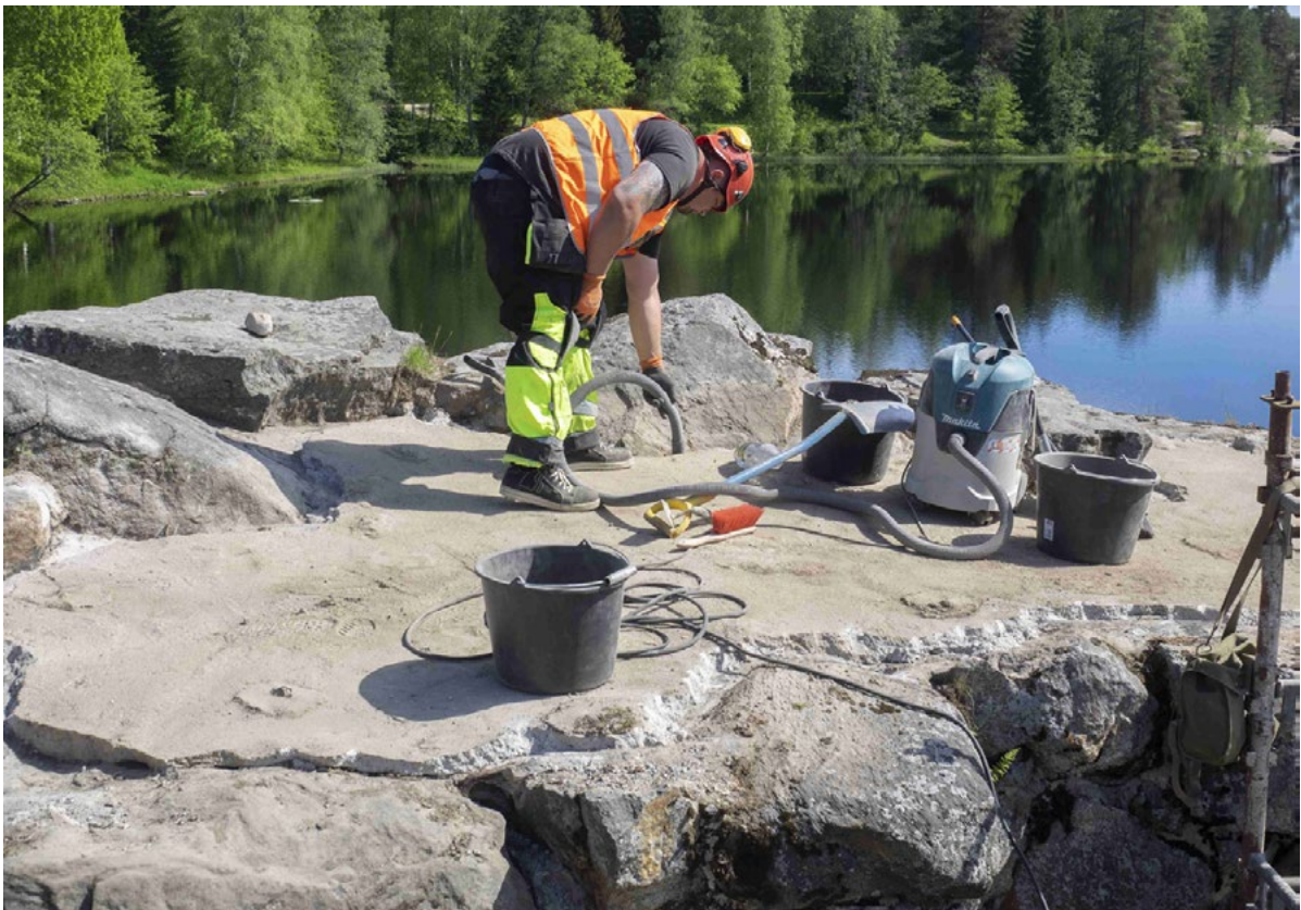
Länsikulman vedeneristyksen korjausta. Rene Rutanen, Kivityö Kaseva Oy puhdistaa avattuja laatan saumoja. Kuva: Pekka Agarh/Kivityö Kaseva Oy.
