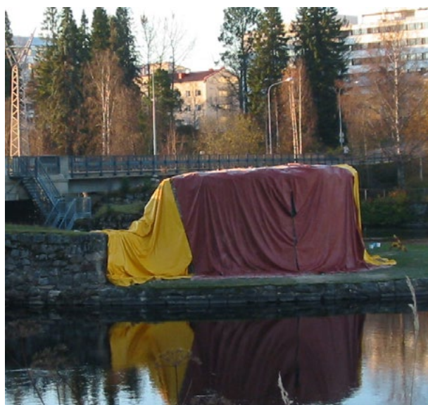
KS-saumausten suojaamista mahdollisilta yöpakkasilta niiden kuivumisaikana, 15.10.2003. Kuva: Sanna Ihatsu.
