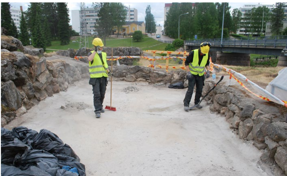
Kellarikaton vedenohjauksen parantamista. Kuva 15.6.2018 Larissa Estifeeva-Auraniemi.
