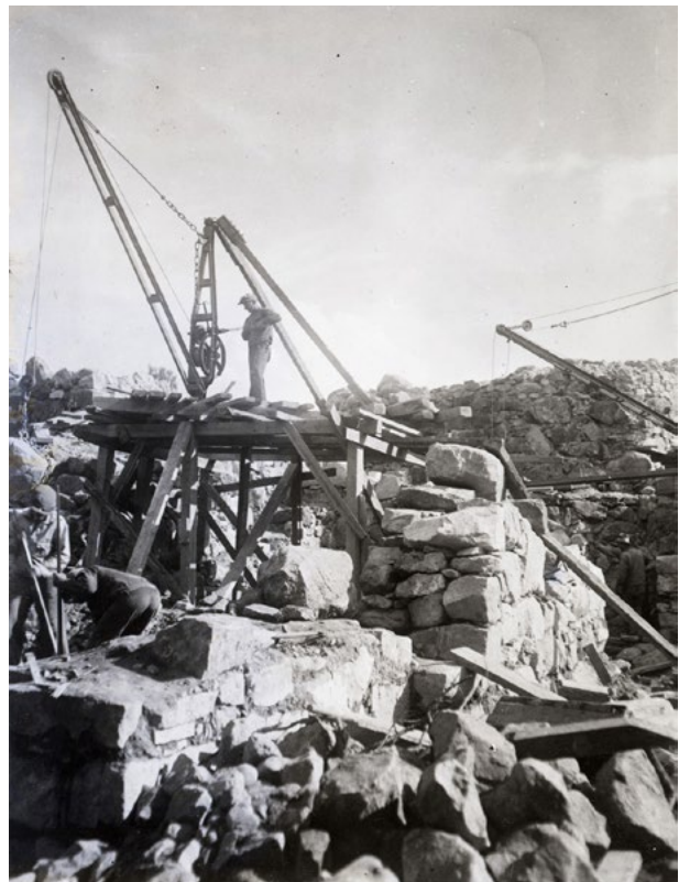
Kivien ja maamassojen nostokalustoa vuodelta 1937. Kainuun museon kuvakokoelma.
