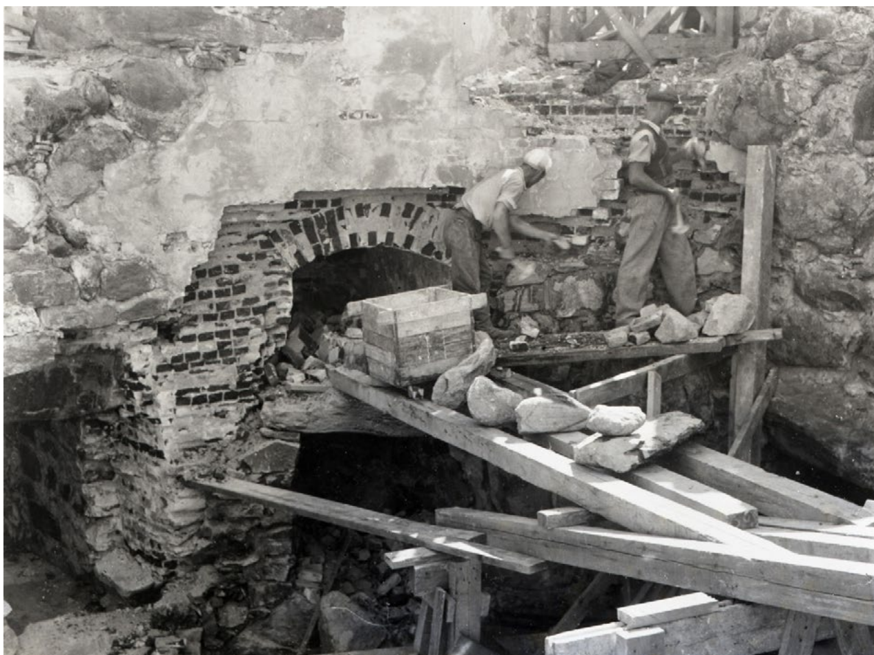
Vuosina 1890–1891 tehtyjä, virheellisinä pidettyjä korjauksia korjattiin ja korvattiin niitä harmaakivi-muurauksella. Kuvassa ylätornissa tehtäviä muutostöitä. Kainuun museon kuvakokoelma.
