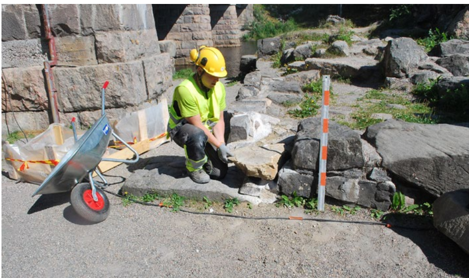
Vankihuoneen irronneiden kiviä kiinnittämistä. Kuva 20.7.2018 Larissa Estifeeva-Auraniemi.
