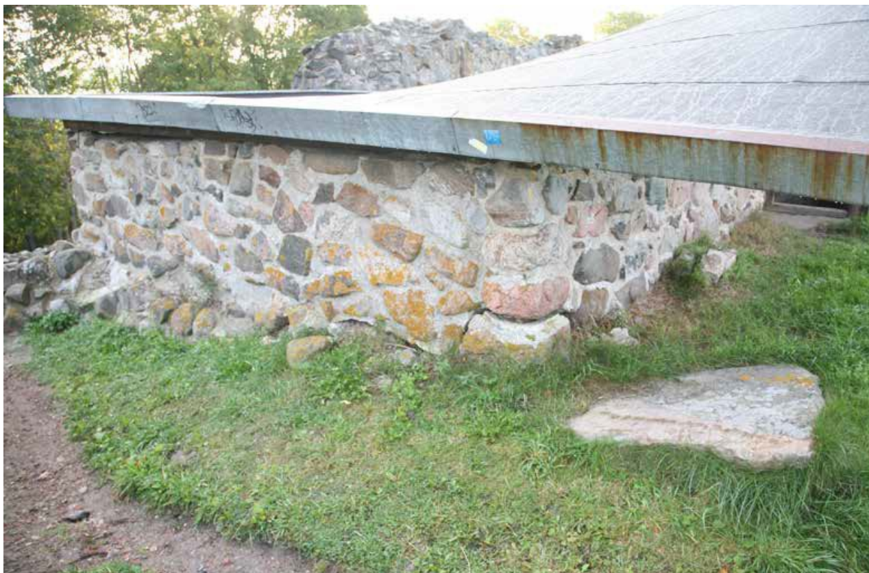
Kuva 26. H-kellari. Ulkoseinä 2014 / KU.
