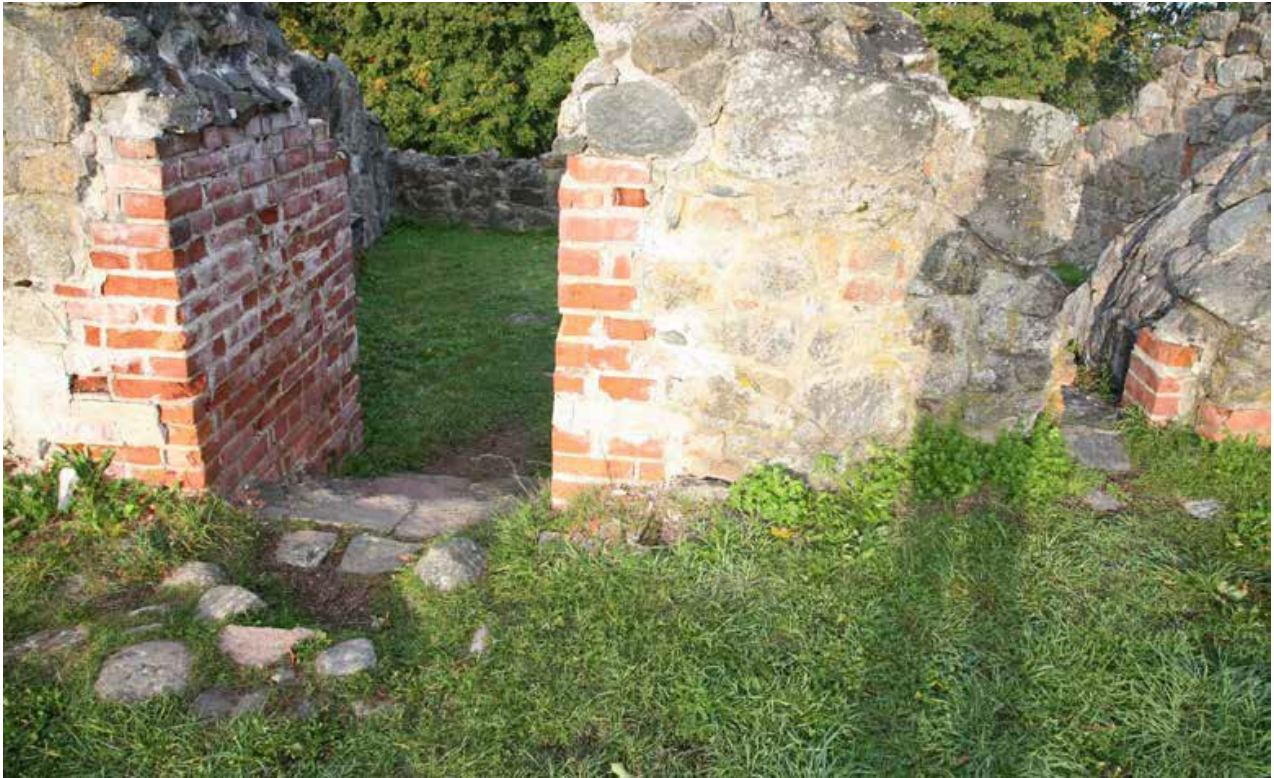
Kuva 22. I-huone. Itäseinän oviaukko. 2014 / KU.
