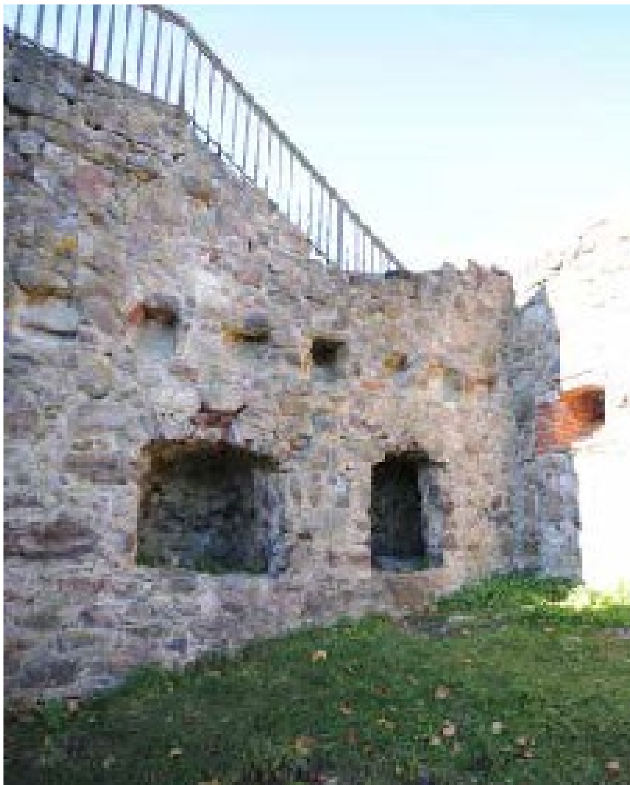
Kuva 14. R-huone. Länsiseinä. 2014 / KU.
