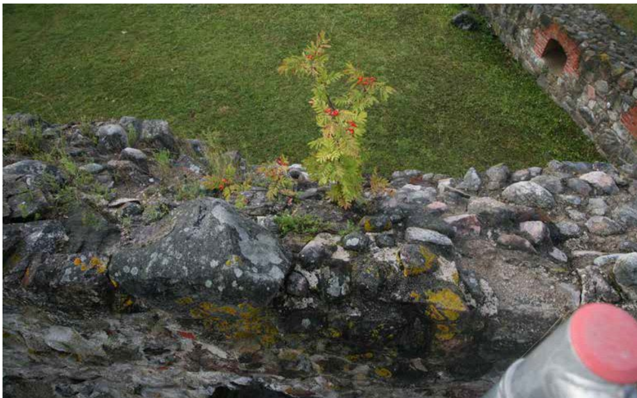
Kuva 3. M-huone. Eteläseinän ulkopinta. 2014 / KU.
