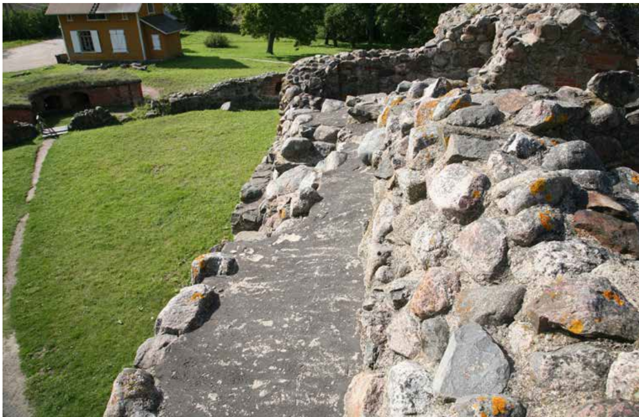
Kuva 21. R-huone. Ulkomuurin tasanne. 2014 / KU.
