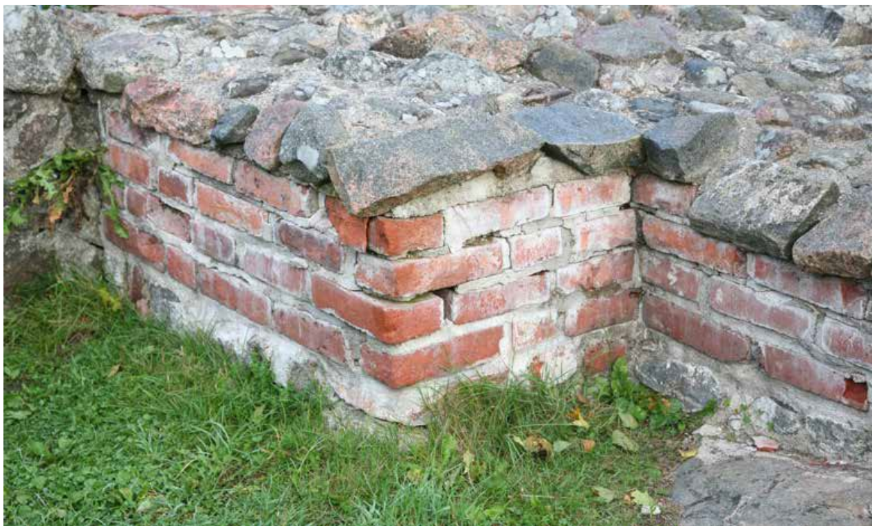
Kuva 25. I-huone. Länsiosan tiilirakenne. 2014 / KU.
