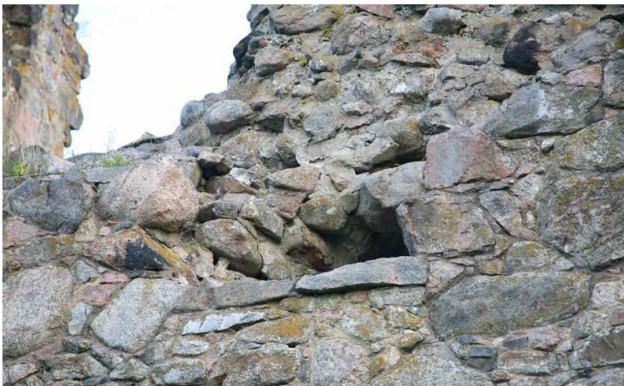
Kuva 6. M-huone. Eteläseinän ulkopinta. 2014 / KU.
