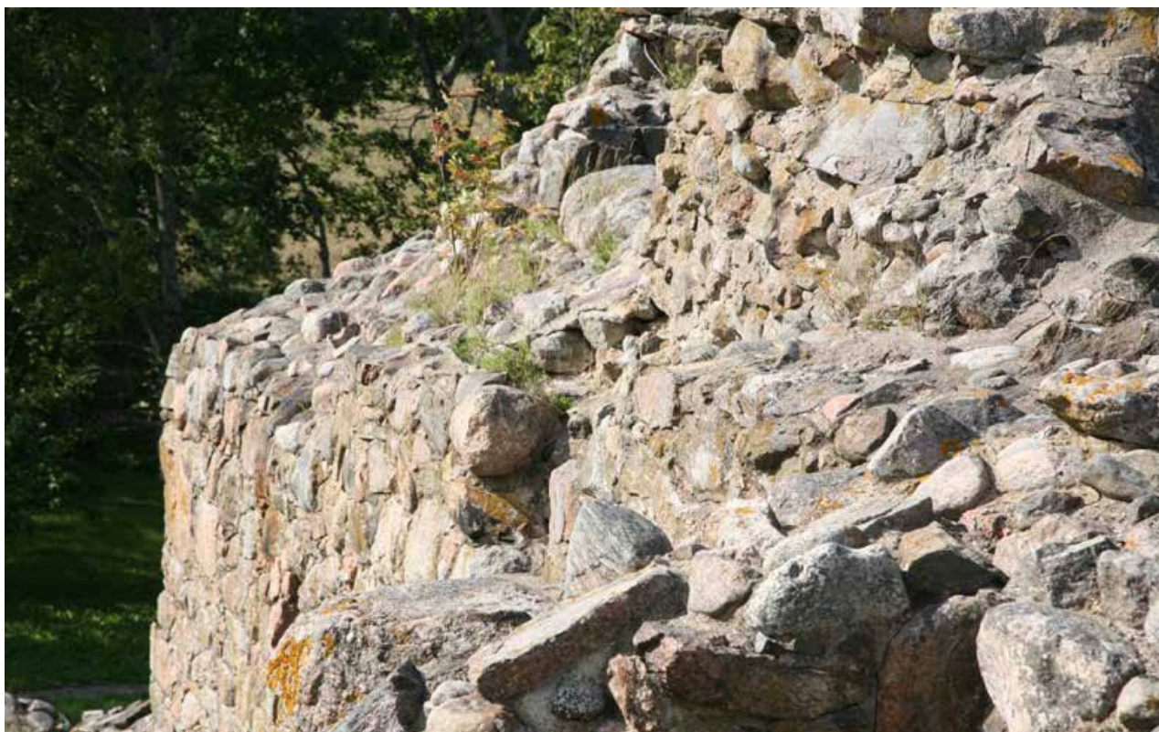
Kuva 4. M-huone. Eteläseinän ulkopinta. 2014 / KU.
