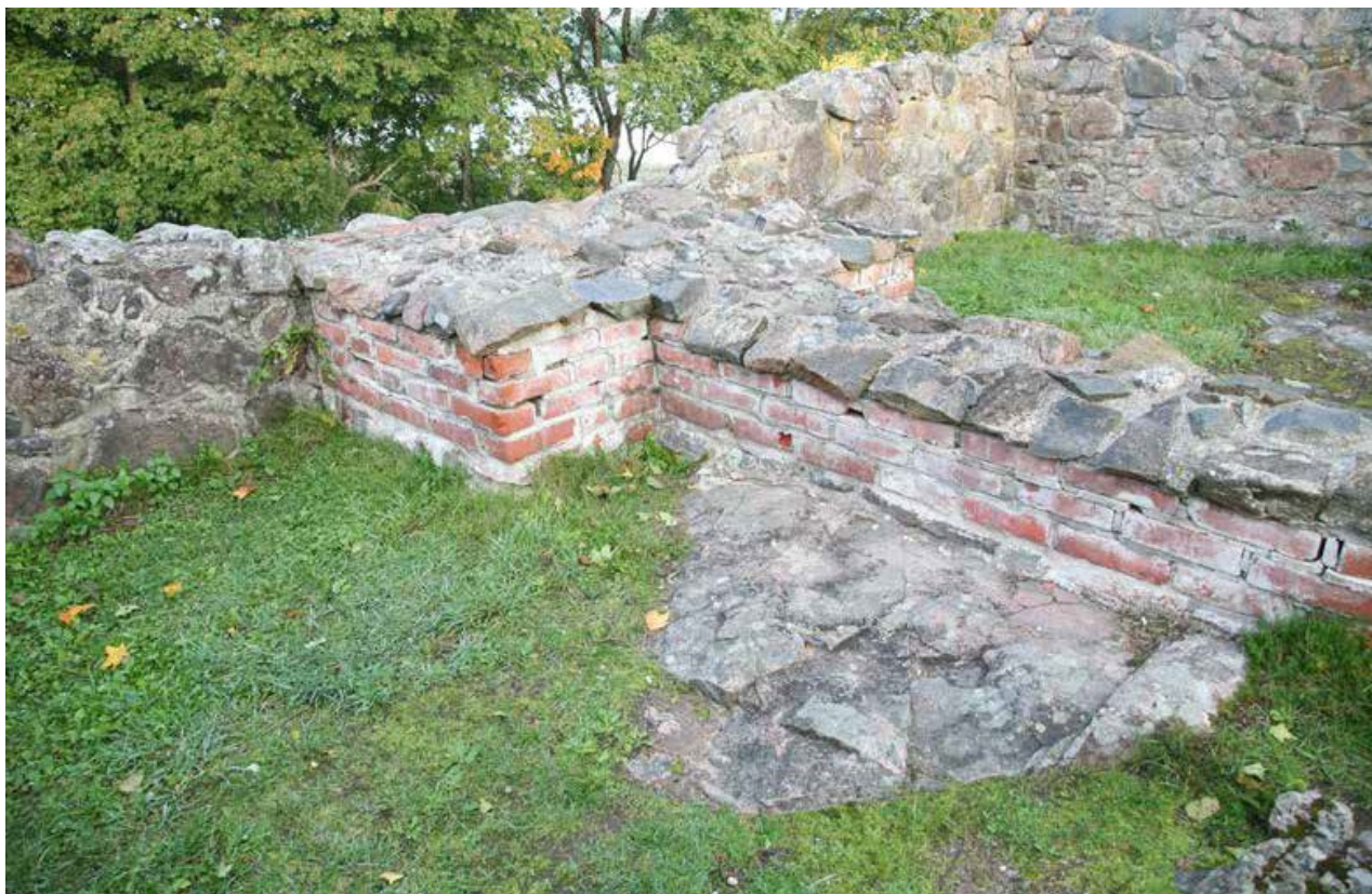
Kuva 24. I-huone. Länsiosan tiilirakenne. 2014 / KU.
