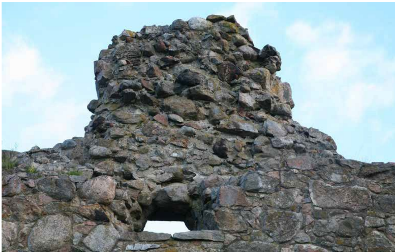
Kuva 5. M-huone. Eteläseinän ulkopinta. 2014 / KU.
