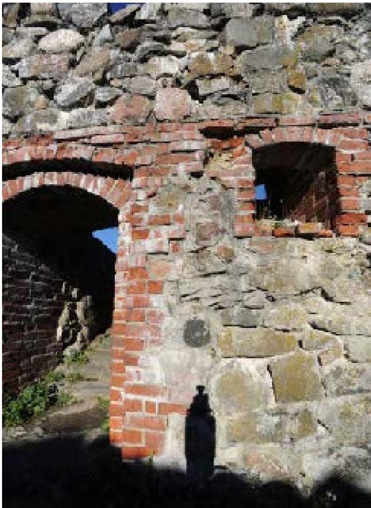
Kuva 15. R-huone. Länsiseinä. 2014 / KU.
