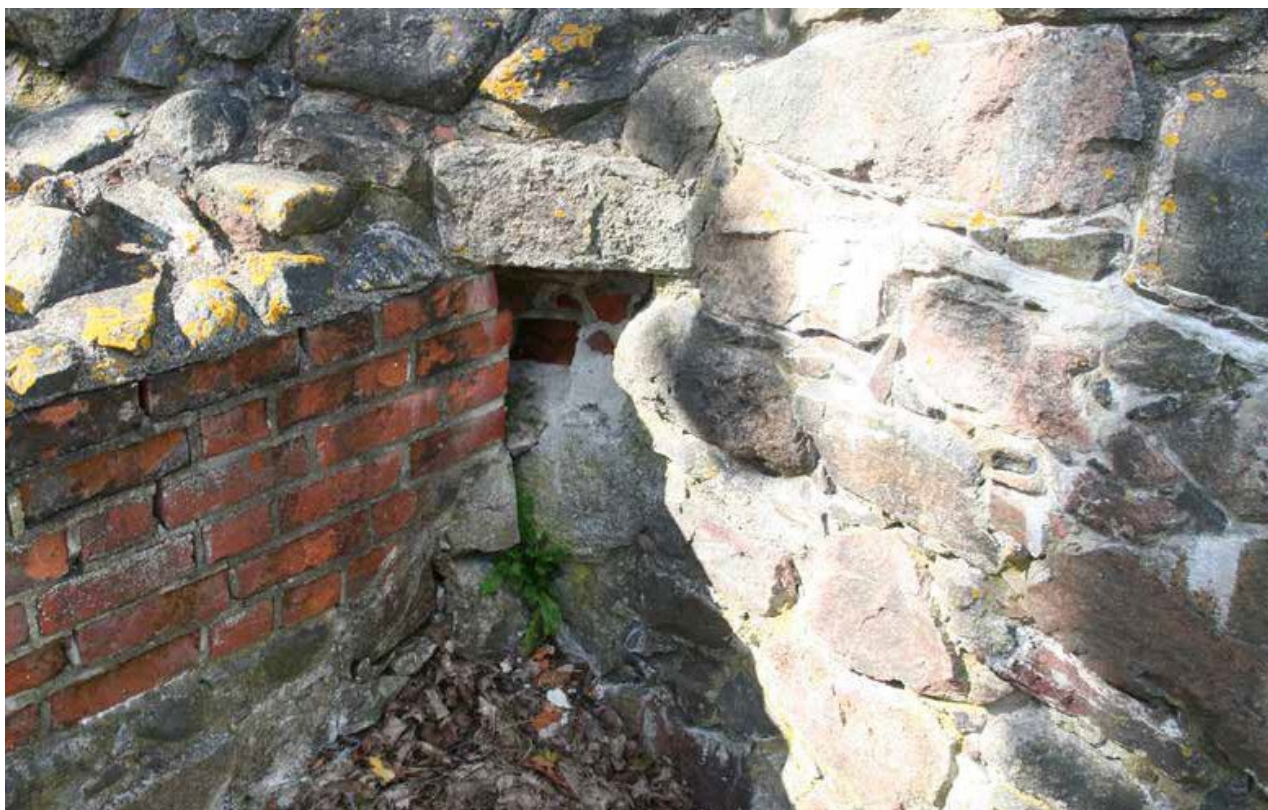
Kuva 19. C-torni. Länsiseinä. 2014 / KU.
