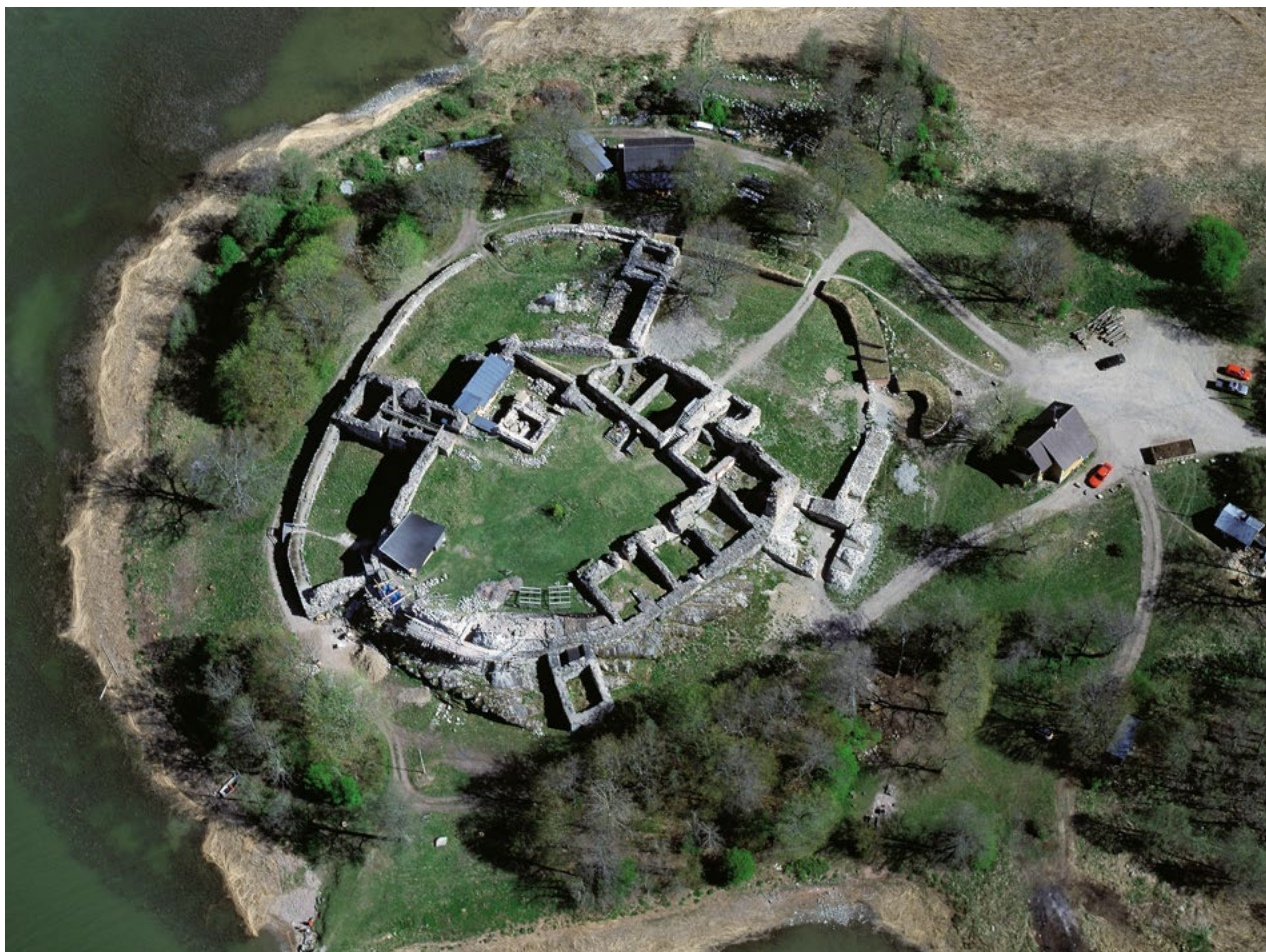
Korjaustyöt käynnissä pohjoismuurilla. Lentokuva Hannu Vallas 1999, finna.fi.
