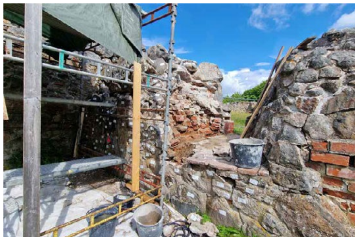
Muurinkorjaustyön alkuvaihe I-huoneen sisäpuolelta kuvattuna. Kuva: Uotila & Lahti 2024.
