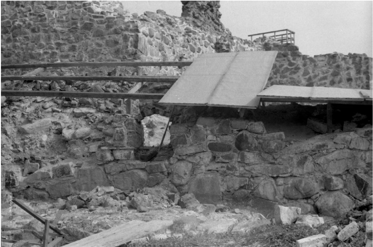
Päiväämätön kuva todennäköisesti vuodelta 1966. Esilinnan läntisen muurin korjausta väliaikaisen katteen alla. Kuusiston linnan rauniot. Valokuva: Museovirasto, rakennushistorian kuvakokoelma. RHO126346:1469, finna.fi.
