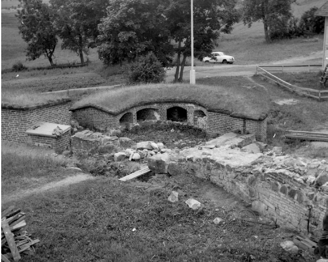
Esilinna I:n kehämuurin ja B-tornin suojamuuraus ja kate. Kuusiston linnan rauniot. Valokuva: Museovirasto, rakennushistorian kuvakokoelma. RHO126346:1160, finna.fi.
