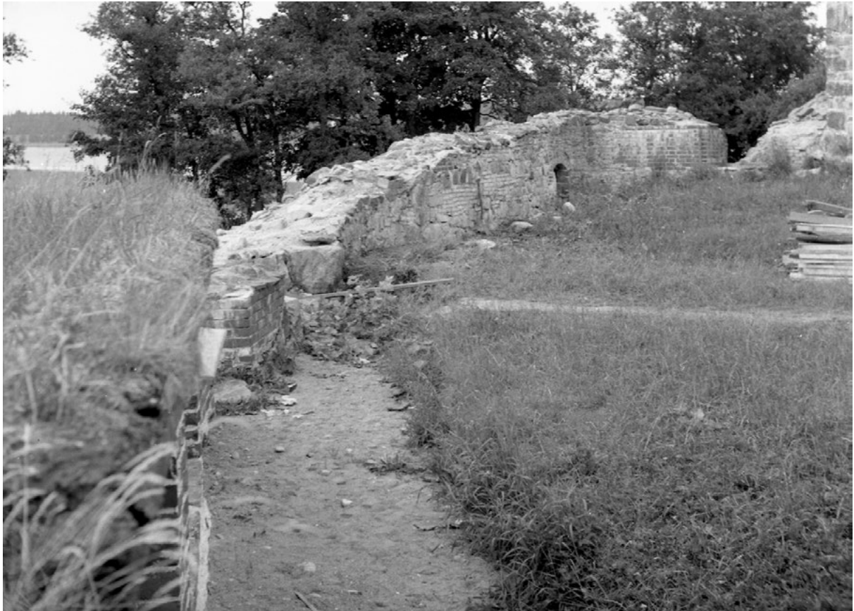
Esilinna I:n kehämuuria ennen suojamuurauksen rakentamista. Kuusiston linnan rauniot. Valokuva: Museovirasto, rakennushistorian kuvakokoelma, RHO126346:1182, finna.fi
