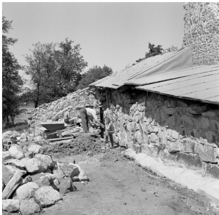
A-tornin länsiseinän perustusten vahvistusta vuosina 1966–1968. Kuvassa työntekijöitä, ajoittamaton. Kuusiston linnan rauniot. Valokuva: Museovirasto, rakennushistorian kuvakokoelma. RHO126346:1246, finna.fi.
