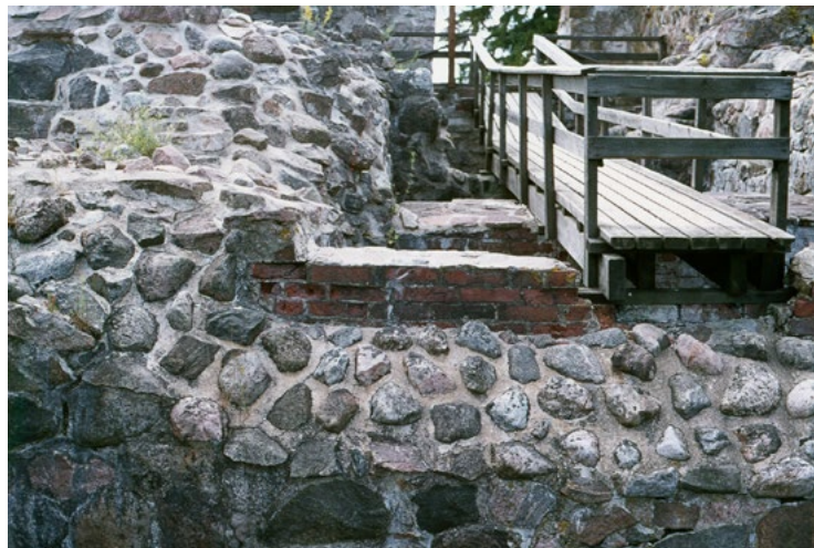
Muurirakennetta ja kulkusilta F- ja E-huoneiden yli vuonna 1975. Kuusiston linnan rauniot. Valokuva 1975. Museovirasto, rakennushistorian kuvakokoelma. RHO11273:159, finna.fi.
