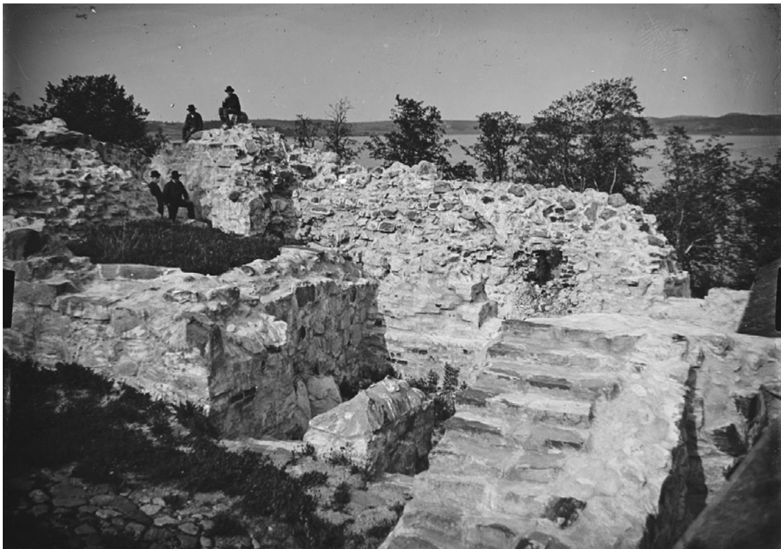
Kuva sisäpihalta etelän suuntaan kohdasta, jossa nykyisin on portaat katselutasanteelle. Muurin päällystystä on korjattu laastitsemalla. Kuusiston linnan rauniot. Valokuva: Reinhold Hausen, 1904. HK19411231:285, Museovirasto, historian kuvakokoelma. Finna.fi.
