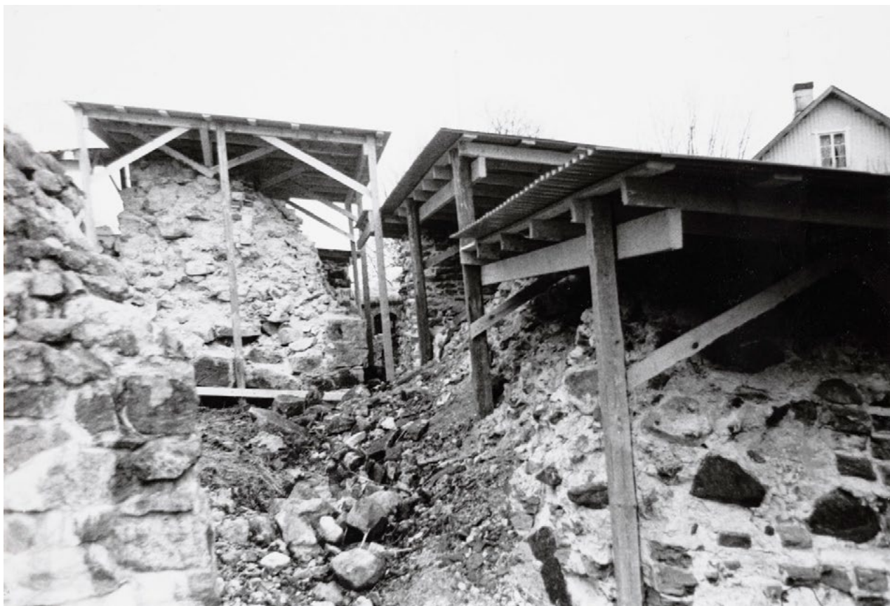
Tornin A ja läntisen muurin päälle rakennetut katokset. K. Heinämies 9.5.1979, MVA.
