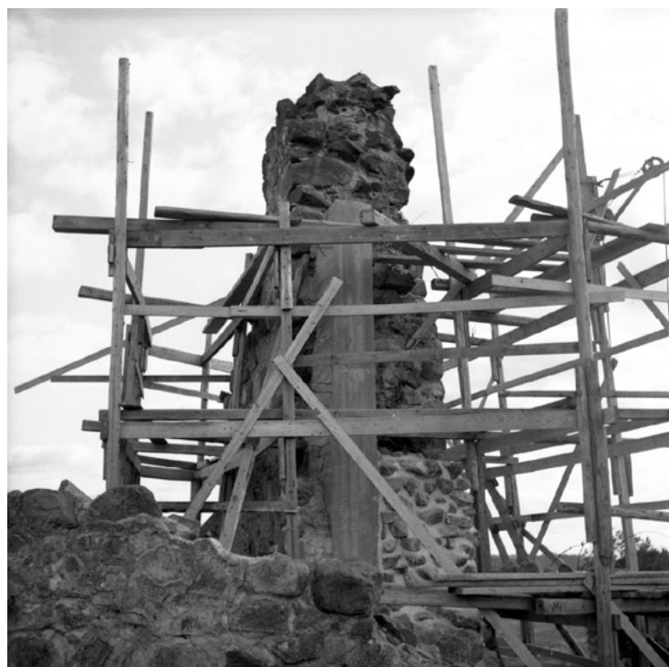
M-huoneen korkean osan tuentatyö käynnissä. Kuusiston linnan rauniot. Valokuva: Museovirasto rakennushistorian osasto, RHO126346:1405 finna.fi
