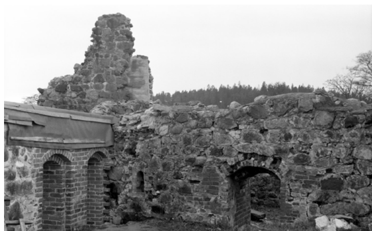
Kuva sisäpihan puolelta, M- ja N-huoneisiin johtavat ovet vasemmalla ja L-huoneen ovi oikealla. Takana näkyy M-huoneen korkean osan betonituki, joka tehtiin 1964. Kuva päiväämätön, arviolta 1960-luvun puolivälistä. Kuusiston linnan rauniot. Valokuva: Museovirasto, rakennushistorian kuvakokoelma. RHO126346:2641, finna.fi.
