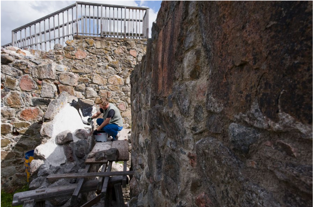
Muurin vesieristys tekeillä, Jari Venhe tekemässä muurin vesieristystä. Valokuva: Vesa Aaltonen, 2008. Museovirasto, rakennushistorian kuvakokoelma. RHO125959:39, finna.fi.
