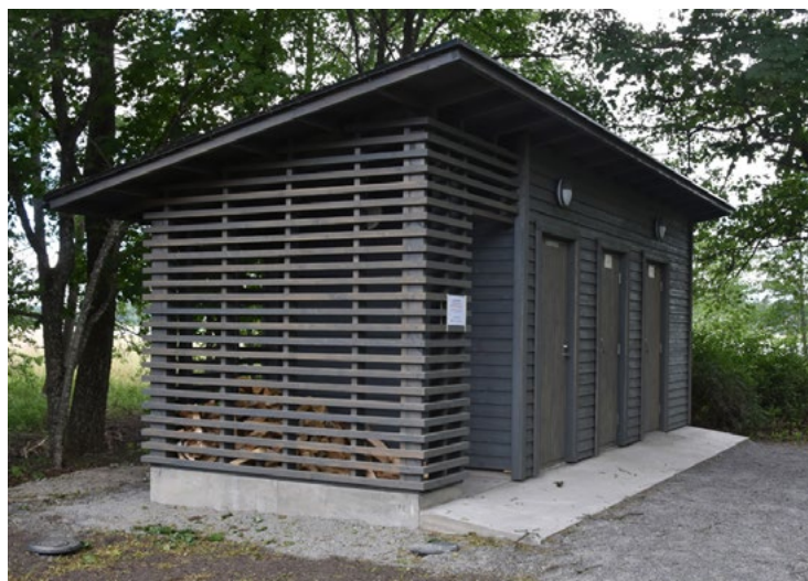
Vuonna 2018 valmistunut wc-rakennus. Kuva: Sanna Ihatsu.
