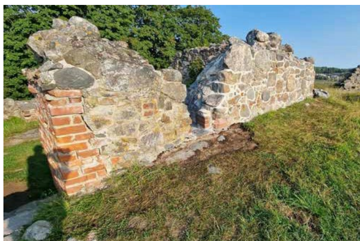
Muurinkorjaus valmiina ulkopuolelta kuvattuna. Kuva: Uotila & Lahti 2024.
