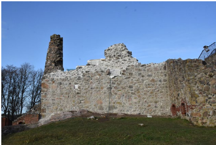
M-huoneen korjaustyön vaihe marraskuussa 2020. Kuvat: Sanna Ihatsu.
