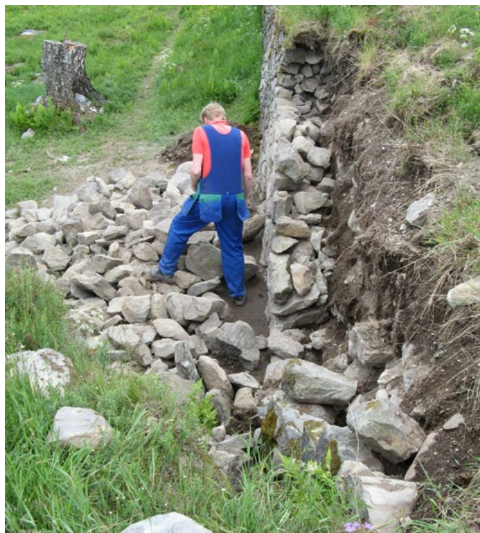
Sidosten muodostaminen sidekivien avulla taustakiveykseen ja taustakiveyksen puhdistaminen routivasta humusmaasta on tärkeää, jotta saadaan aikaan kestävä korjaus. Monissa tehdyissä korjauksissa sidokset ovat olleet puutteellisia ja humusmaata ja hiekkaa on jätetty taustarakenteeseen. Kuva: Päivi Eronen, Kärnäkosken Linnoitus. Läntinen puolibastioni koillisesta 2008, RHO, Museovirasto.
