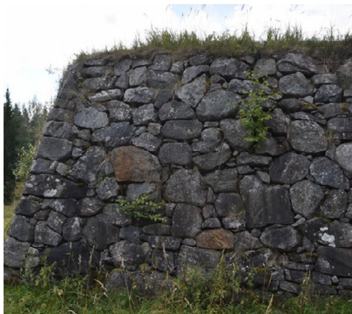
Tiivistä ja huolellisesti muurattua muuria. Muuri koostuu muokatuista kivistä. Kuva: Sanna Ihatsu.
