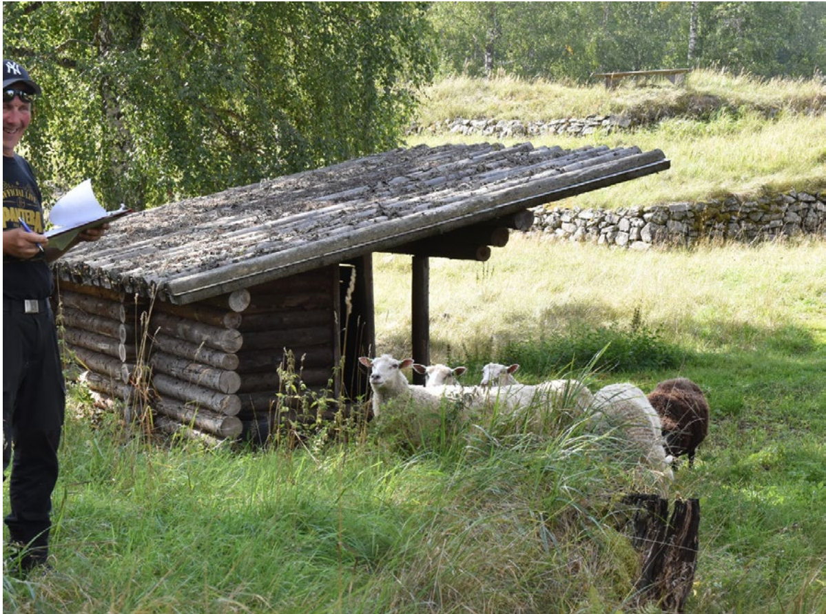
Linnoituksen pohjoisosaan on rakennettu malkakattoinen lammassuoja, joka toteutettiin Hentosen suunnitelmien mukaan vuonna 1988. Kuva: Sanna Ihatsu.
