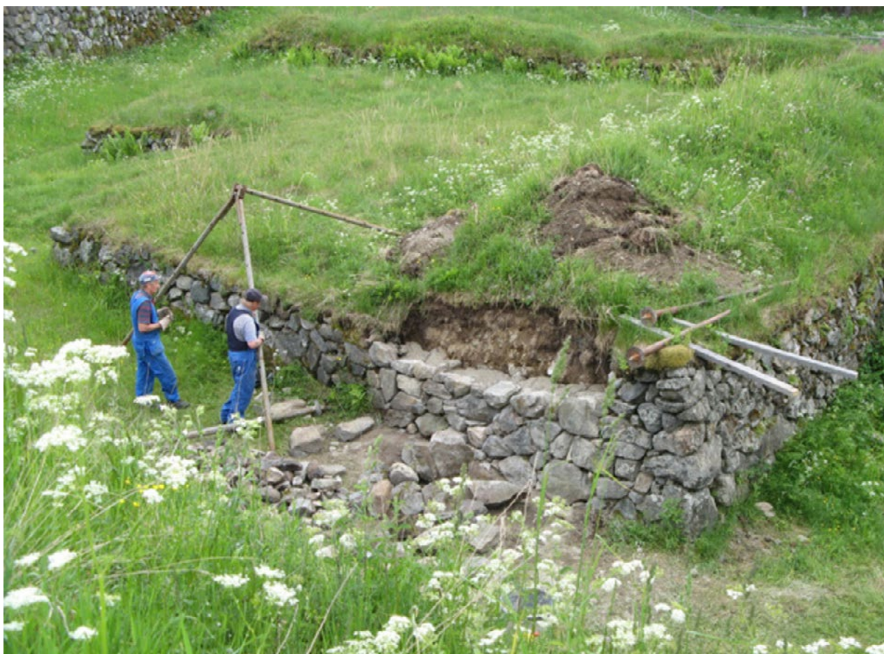
Ravelliini B:n korjaustyö. Muuria on purettu ja uudelleenladottu ja vesieristyskerrokset ovat tekeillä. Kivien nosteluun käytettiin kolmijalkaa ja sähkötaljaa. Kuva: Päivi Hakanpää 2008, MV.
