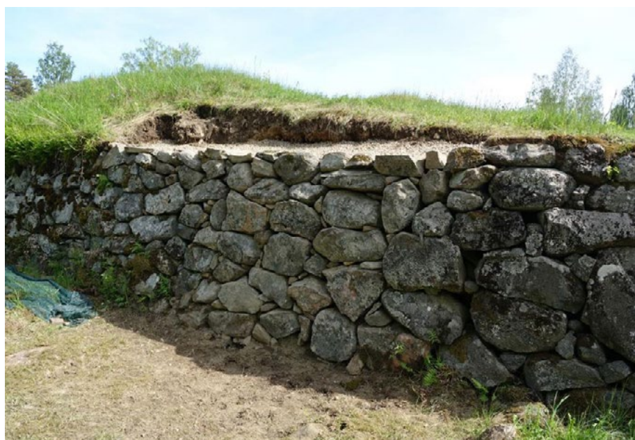
Ravelliini B:n kärjen tuntumassa oleva vauriokohta korjattuna. Muurinharjan laastivalu vielä puuttuu. Kuva: Tuija Väli-Torala, MH.
