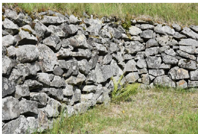
Harvaa ja muokkaamattomista kivistä ladottua muuria. Kuva: Sanna Ihatsu.
