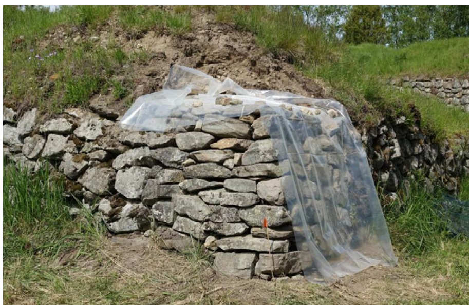
Ravelliini B:n vasemman sivun ja kyljen välinen nurkka uudelleen ladottuna. Päällisen laastivalu tehty ja valun jälkihoito käynnissä. Kuva: Tuija Väli-Torala, MH.
