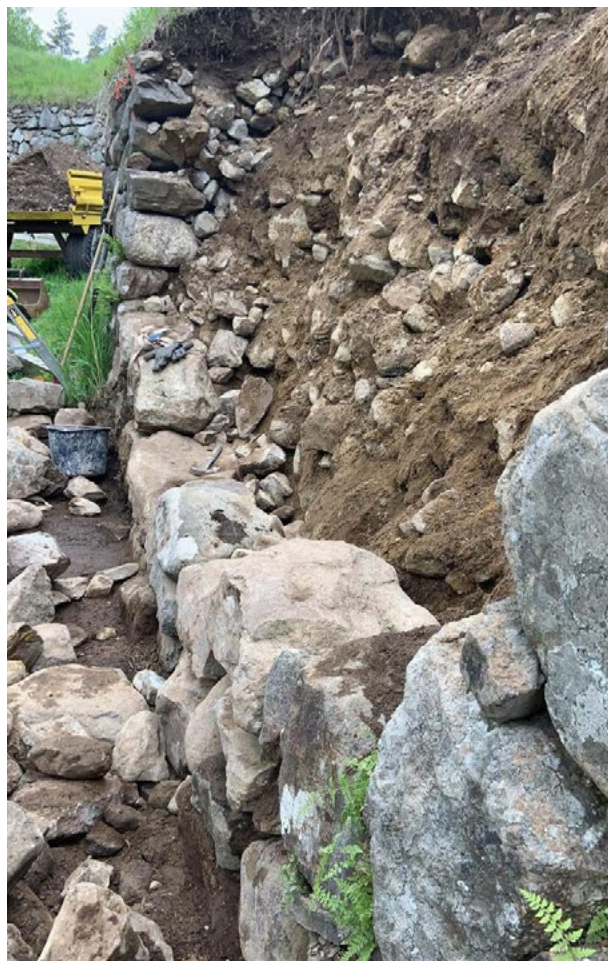
Ravelliini C:n oikea sivu. Sortuma purettu koko vaurioalueelta alas asti ja kivien uudelleenladonta käynnissä. Kuva restaurointiraportista: Väli-Torala, korjaustyöt 2021–2022, MH. Kuva: Mikkelin Kivityö MKT Oy.
