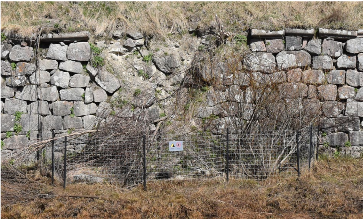
Esimerkki lammasaidalla aidatusta sortuma-alueesta Kyminlinnassa. Puiset tolpat on käsitelty Uulan Roslagin Mahongilla, jossa on tervaa. Aita 100 x 100 mm silmäjaolla, 1 500 mm korkea, Jokioisten lankatehdas. Kuva: Sanna Ihatsu.
